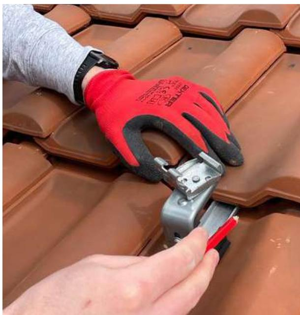
**REMARQUE :** Pour une installation en position verticale, veuillez tourner la tête du crochet de fixation à 180°, en passant ainsi sa position de verticale à horizontale. Cette étape de l'installation a lieu lors de la fixation des rails, mais il est important de la prévoir lors du dimensionnement et du positionnement de vos crochets de fixation.
