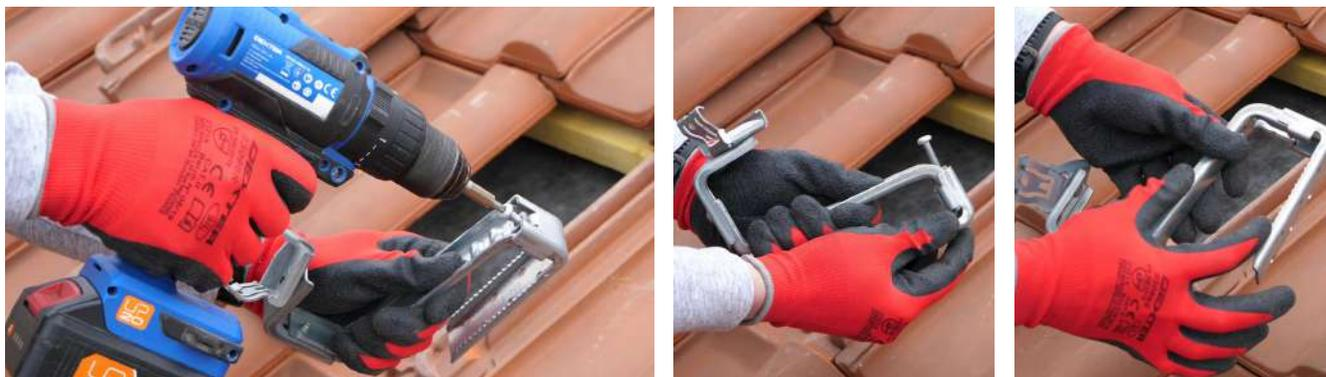
3.1. Dévissez et ouvrez d'abord tous les crochets de fixation pour une installation plus efficace
