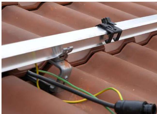
7.9. Soulevez la tuile pour passer le câble d'alimentation entre les micro-onduleurs et le tableau électrique.
