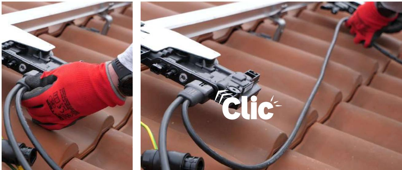
8.1. Connectez les micro-onduleurs entre-eux à l'aide du câble bus.
