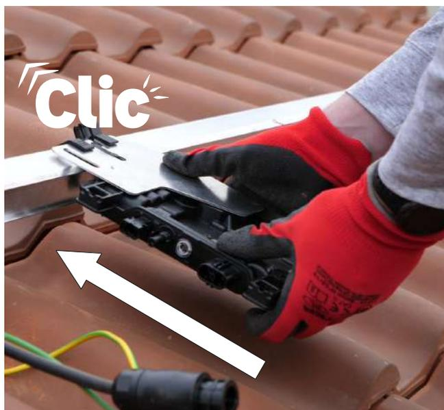
7.11. Fixez le micro-onduleur sur le crochet, jusqu'à entendre «Clic».
