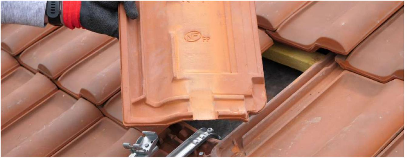
4. 5. A l'aide d'une meuleuse électrique ou d'une lime manuelle, rabotez la tuile jusqu'à ce qu'elle se repositionne correctement.
