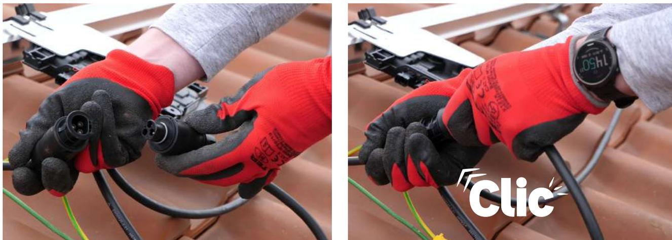
8.3. Connectez le câble bus au câble 3G2,5mm<sup>2</sup> qui va jusqu'au coffret AC.
