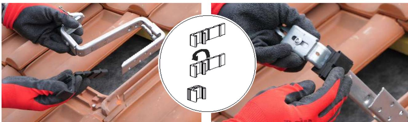
3.2. Pliez le caoutchouc pour obtenir l'épaisseur souhaitée. Les rembourrages sont de 5,10 et 15 mm. Le but du caoutchouc est de ne pas avoir de contact entre les tuiles et les crochets.
