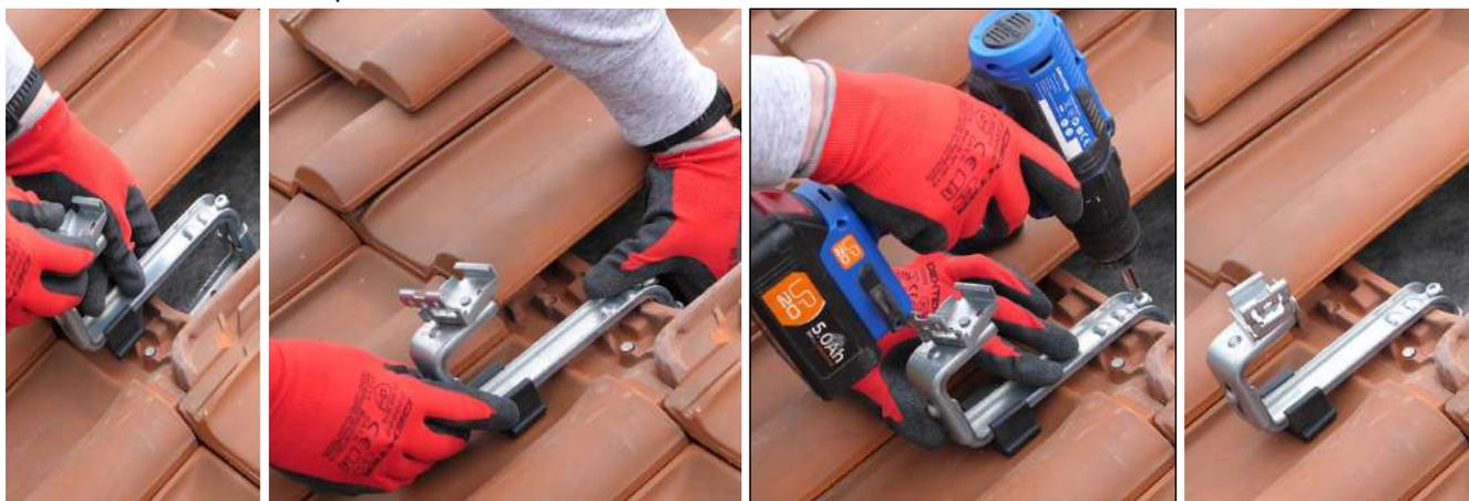
3.3. Mettez les crochets en les fixant dans la tuile.
