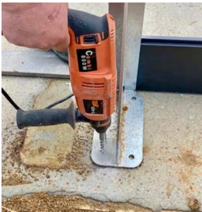
Placez bien les poteaux suivant le plan (bien mettre d'aplomb), puis percez bien verticalement 4 trous sur la chape à l'aide d'un perforateur équipé d'un foret béton de  $\varnothing 12\text{mm}$ , en utilisant le poteau comme gabarit. Pour garantir une bonne fixation, la profondeur du perçage devra être de 120 millimètres minimum.
