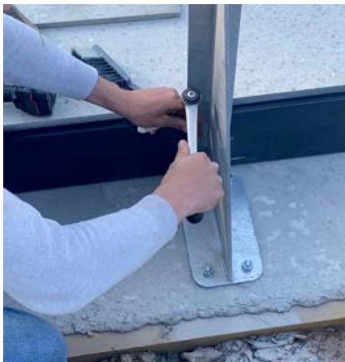
Placez ensuite les goujons d'ancrage, avec rondelles et écrous (non fournis) dans les trous et frappez-les à l'aide d'un marteau. Enfoncez entièrement les goujons d'ancrage (seule la tête doit rester visible). Serrez fermement en croix les 4 écrous à l'aide d'une clé à dynamométrique ou d'une clé à pipe.
