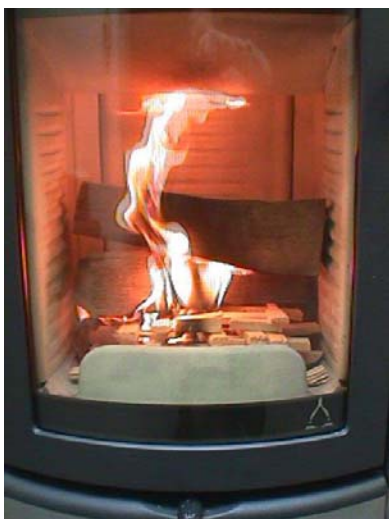
III. 3: Chiudere la presa dell'aria primaria
