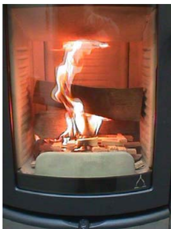
Fig. 5: Primärluftschieber schließen
