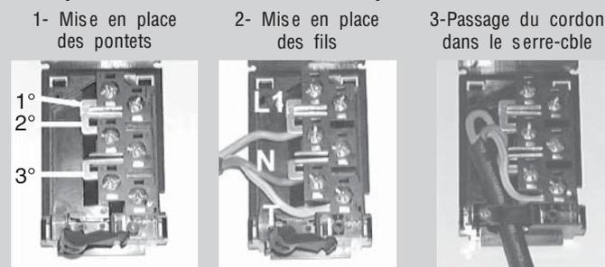
**Attention :** un mauvais serrage peut entraîner des risques d'échauffement dangereux au niveau du câble d'alimentation.
