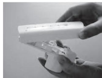
4/ Presente el zócalo y conecte el Neutro (N), la Fase (L) y el cable Piloto (FP). En el caso del modelo 2 zonas, es necesario conectar los 2 cables Pilotos (FPZ1 y FP Z2).
