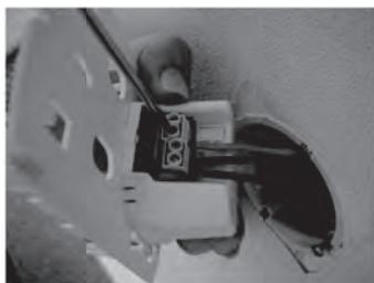
5/Fixez le support dans la boîte d'encastrement standard ( $\varnothing$  60 mm et profondeur  $\geq 40$  mm).
